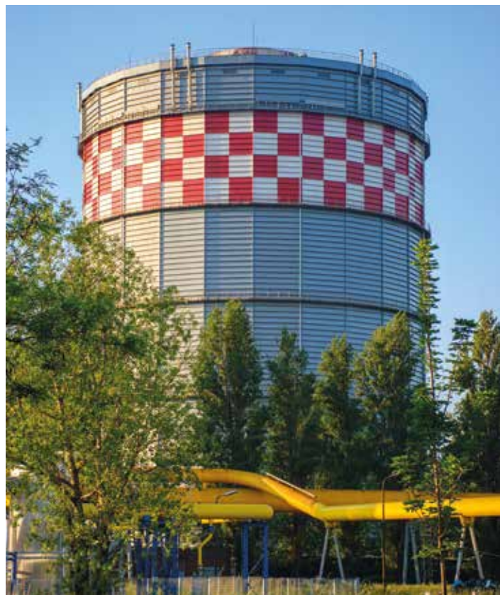
Jelentős projekt volt a 150 000 köbméteres gáztartó irányítástechnikai tervezése, szerelése, beüzemelése, a komplett folyamatszabályozó rendszer kiépítése
